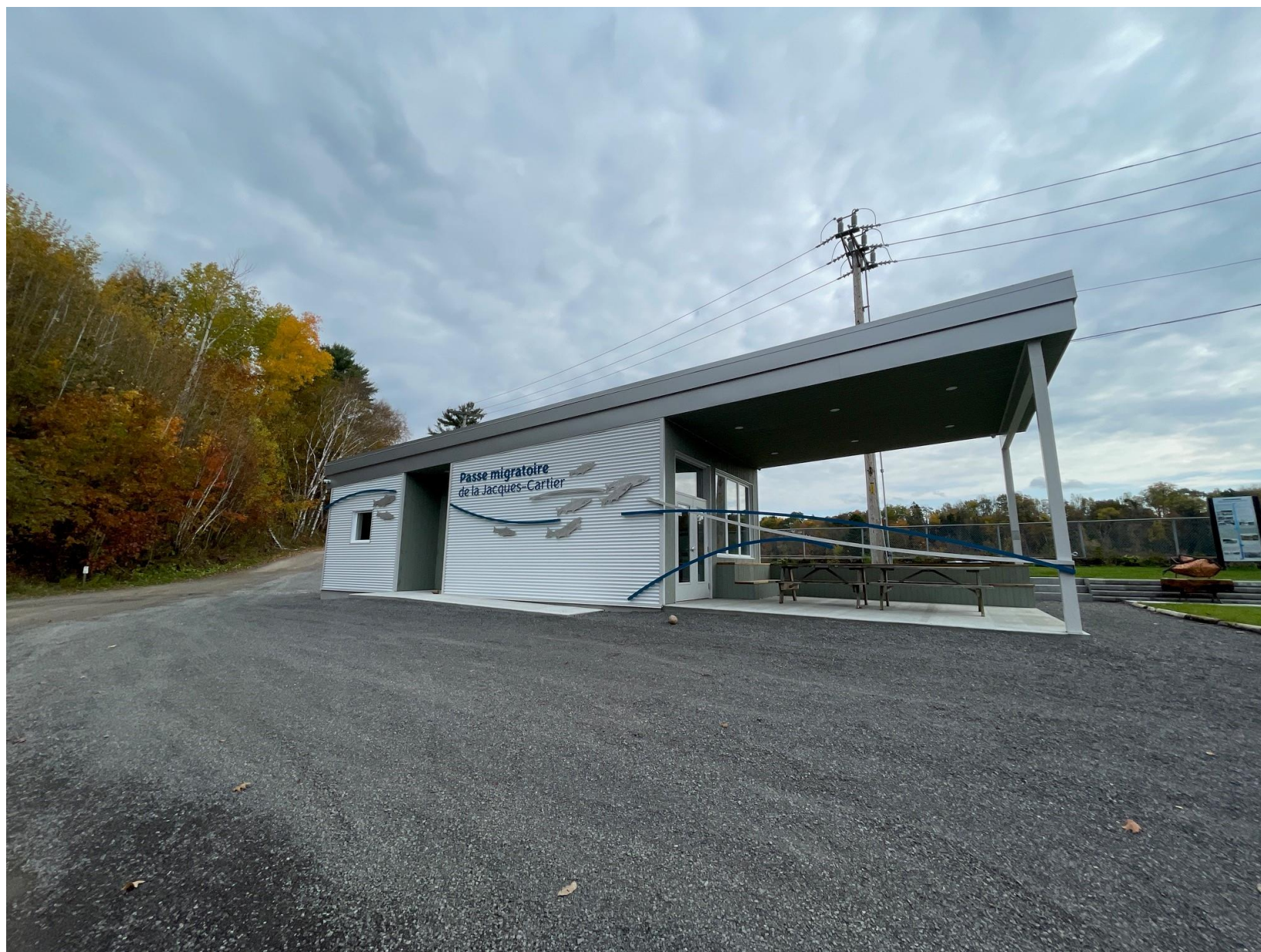
Figure 17 : Nouveau bâtiment d'accueil
