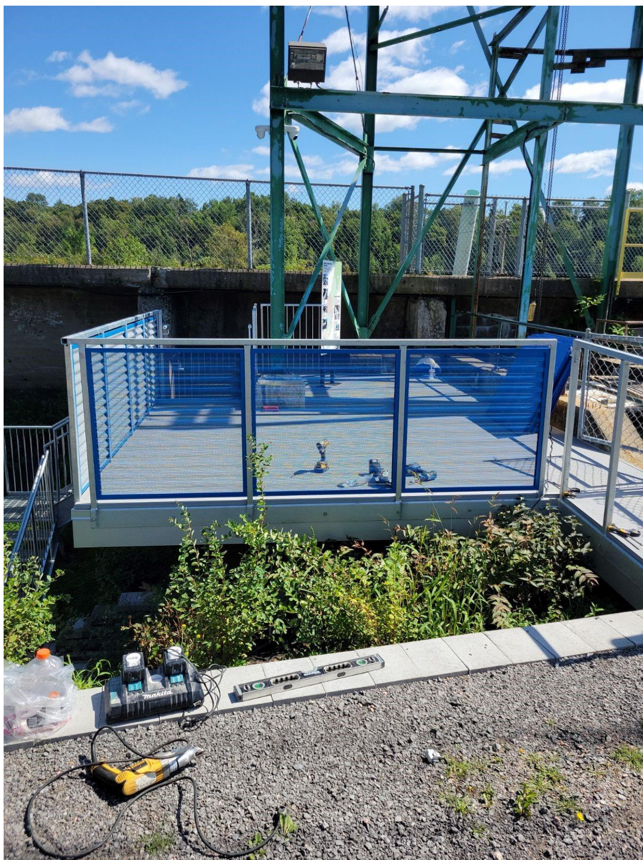
Figure 23 : Plateforme d'observation des manipulations de transport
